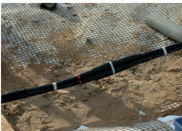
Mufa przejściowa TS24CSJ M70-240
