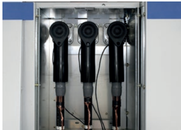
Rozdzielnica SF-6 z głowicami serii M480TB
