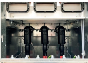
Rozdzielnica SF-6 z głowicami serii K200LR
