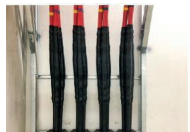
Mufa przelotowa 24CSJ-S M70-240
