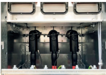
Rozdzielnica SF-6 z głowicami serii K200LR
