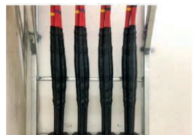
Mufa przelotowa 24CSJ-S M70-240
