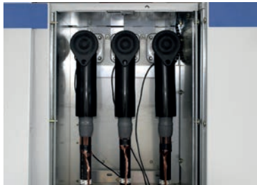
Rozdzielnica SF-6 z głowicami serii M480TB
