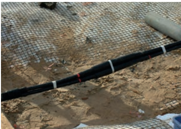
Mufa przejściowa TS24CSJ M70-240
